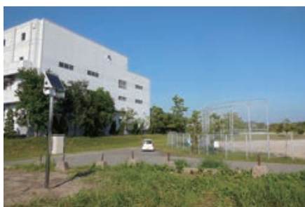
敷地内にある一般の方も利用する グラウンド付近へ設置 某下水道浄化センター様 (高知県)
