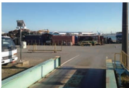
沿岸部の屋外作業場付近へ設置 東海埠頭株式会社様 (静岡県静岡市清水区)
